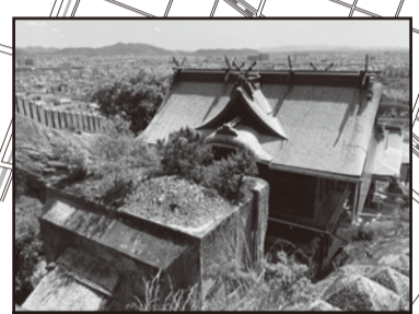
生石神社【おうしこ】(石の宝殿) 生石神社の裏手に、切妻風の突起を後ろにして家を横たえたような横約6.5m、高さ約5.6m、奥行約7.5m、重さ約500tの巨大な石造物があります。「石の宝殿(いしのほうでん)」と呼ばれ、水面に浮かんでいるように見えるところから「浮石(うきいし)」ともいわれています。(拝観料100円)
